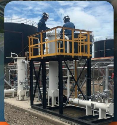
Sistema de filtración y coalescencia para purificación de Diesel
